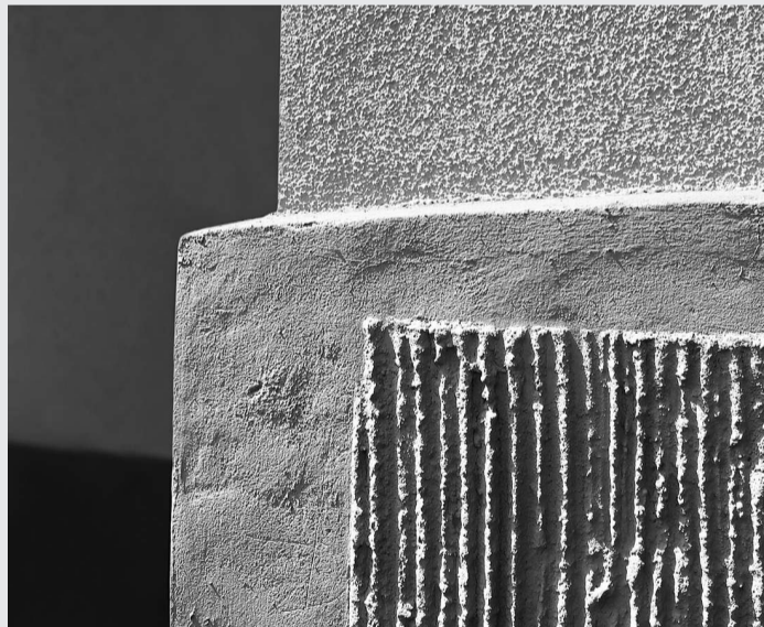
Sockelputz mit Kammzug und freihändigem Glattputz
